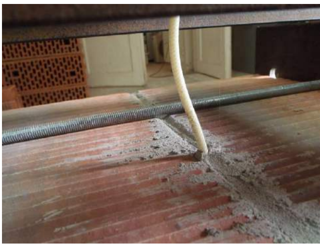
Фото 9. Положение анкера после сжатия в растворе шва под нагрузкой. Видно выкрашивание раствора из шва при сжатии.
