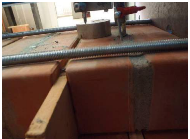
Фото 24. Положение анкера после испытаний образца. Видно выкрашивание частиц раствора из шва при растяжении.
