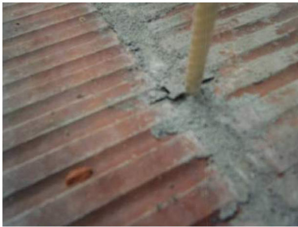
Фото 69. Стержень полимерного анкера после испытания. Видно выкрашивание частиц раствора из шва при вытягивании.
