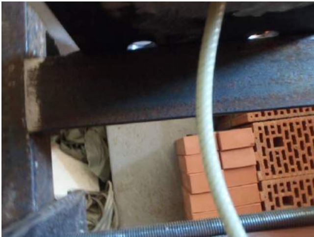
Фото 7. Деформация стержня полимерного анкера после приложения нагрузки.
