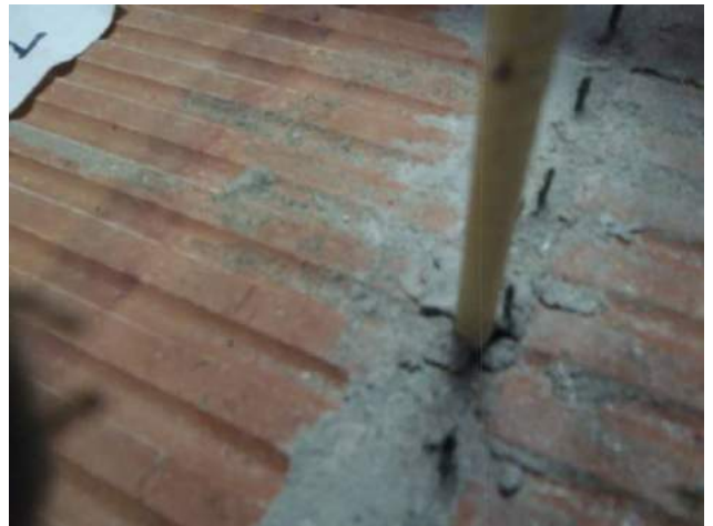
Фото 76. Положение анкера после испытания образца. Видно выкрашивание частиц раствора из шва при вытягивании.
