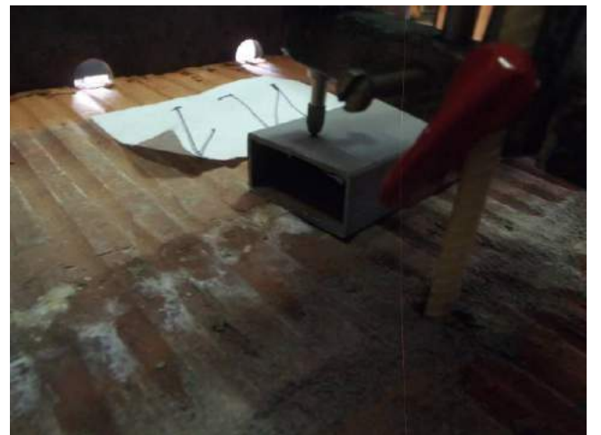
Фото 66. Положение анкера после испытания образца. Видно выкрашивание частиц раствора из шва при вытягивающей нагрузке.
