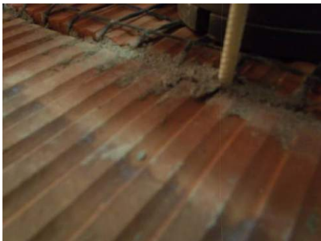
Фото 33. Анкер после испытания. Виден вырыв раствора из шва образца.
