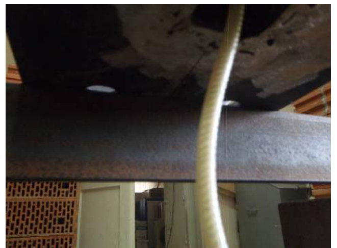
Фото 12. Деформация стержня образца.
