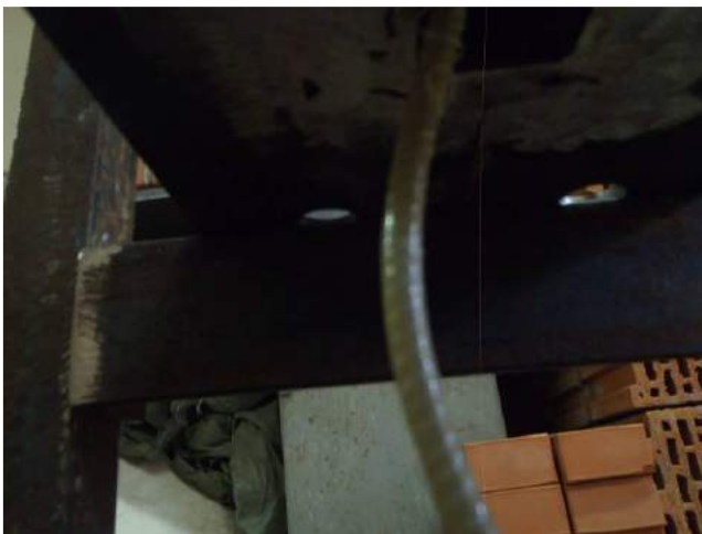
Фото 3. Деформация стержня полимерного анкера после приложения нагрузки.
