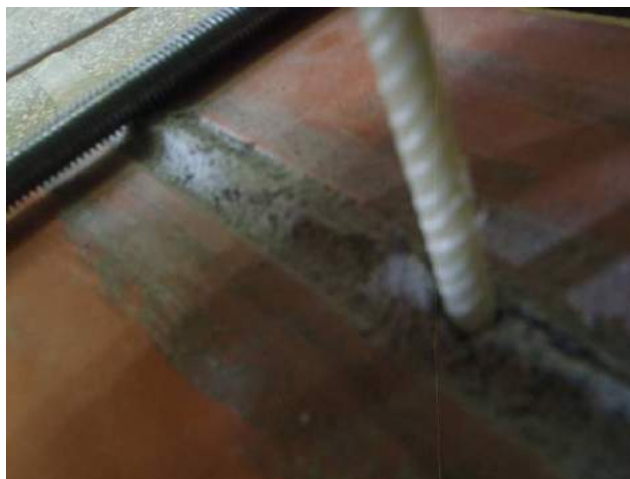
Фото 30. Положение анкера после сжатия в растворе шва.
