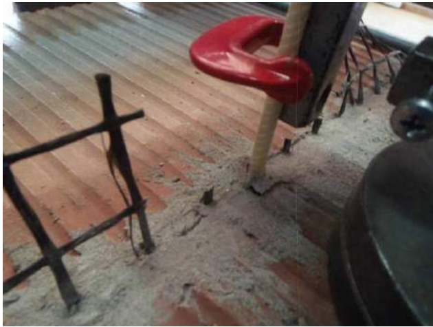
Фото 49. Анкер после испытания. Виден вырыв раствора из шва образца.
