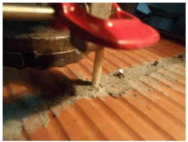
Фото 52. Анкер после испытания. Виден вырыв раствора из шва образца.
