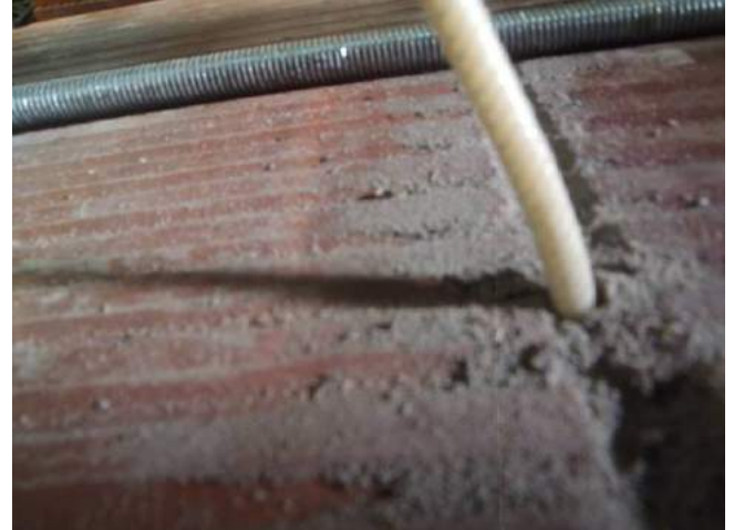
Фото 26. Стандартный растворный шов толщиной 10 мм.
